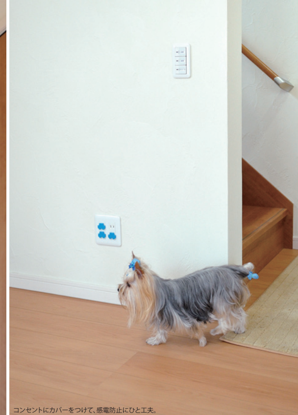
コンセントにカバーをつけて、感電防止にひと工夫。
